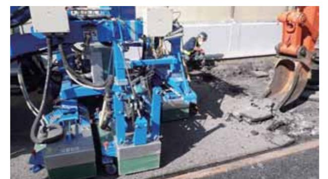
IH式鋼床版舗装撤去工法による舗装撤去
