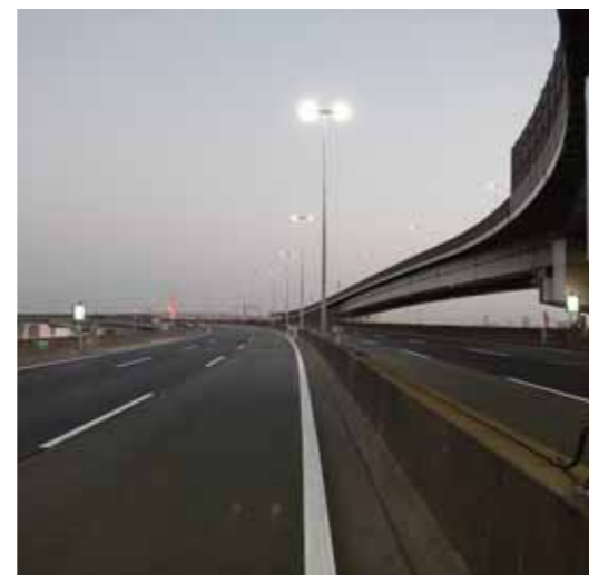
LED道路照明
