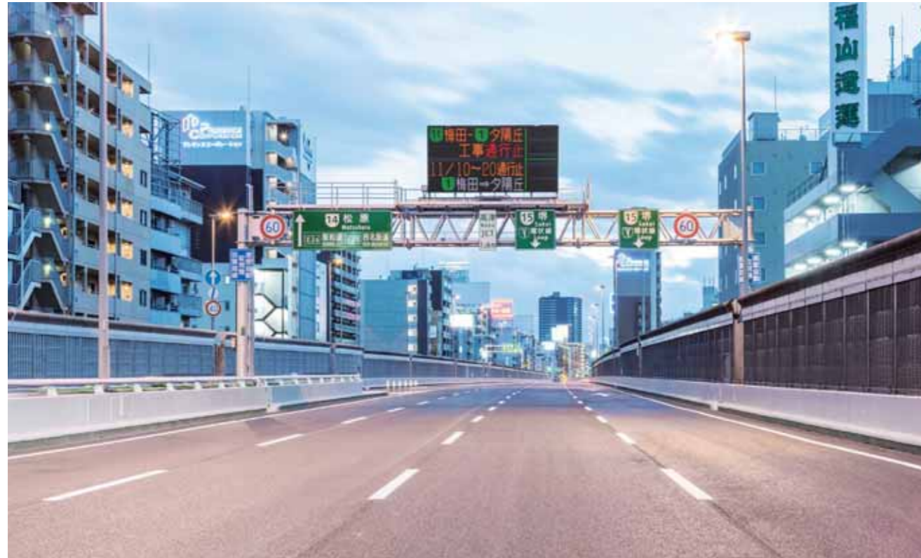
1号環状線リニューアル工事2020南行完了状況
