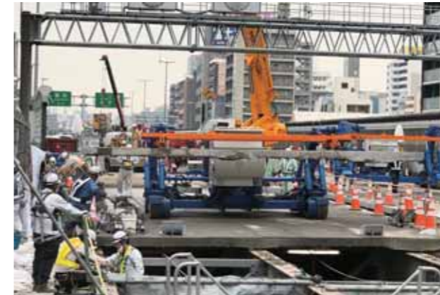
RC床版撤去状況
