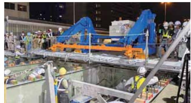
12号守口線床版取替工事における平板型UFC床版設置状況
