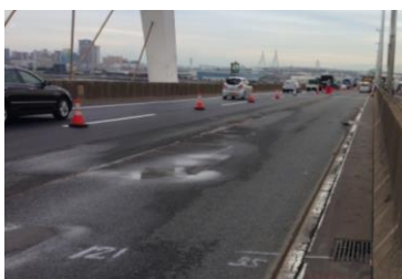
工事前（舗装表面に水たまり有）
