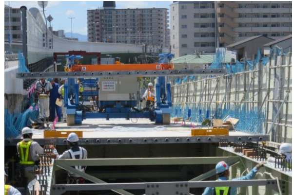
新しい床版の設置
