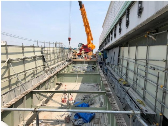
RC 床版の撤去
