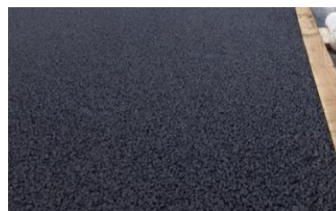
工事後（舗装表面に水たまり無）
