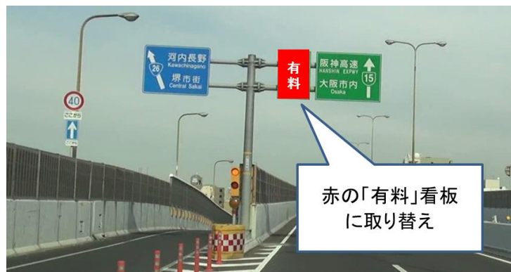
堺入口（国道 26 号直結）の看板の取り替え
