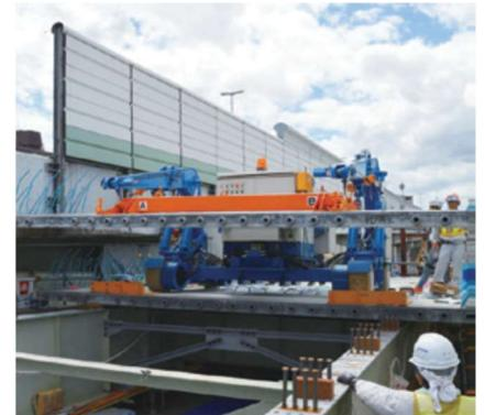
UFC 床版架設工事の状況（玉出入口）
