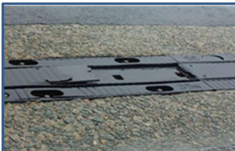
損傷事例（ゴムジョイントのはがれ）
