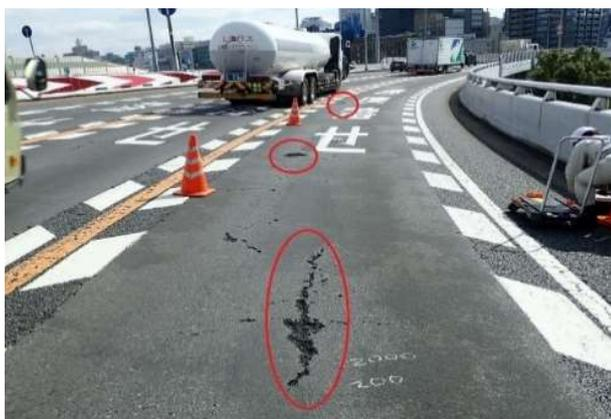
1号環状線の舗装の損傷状況
