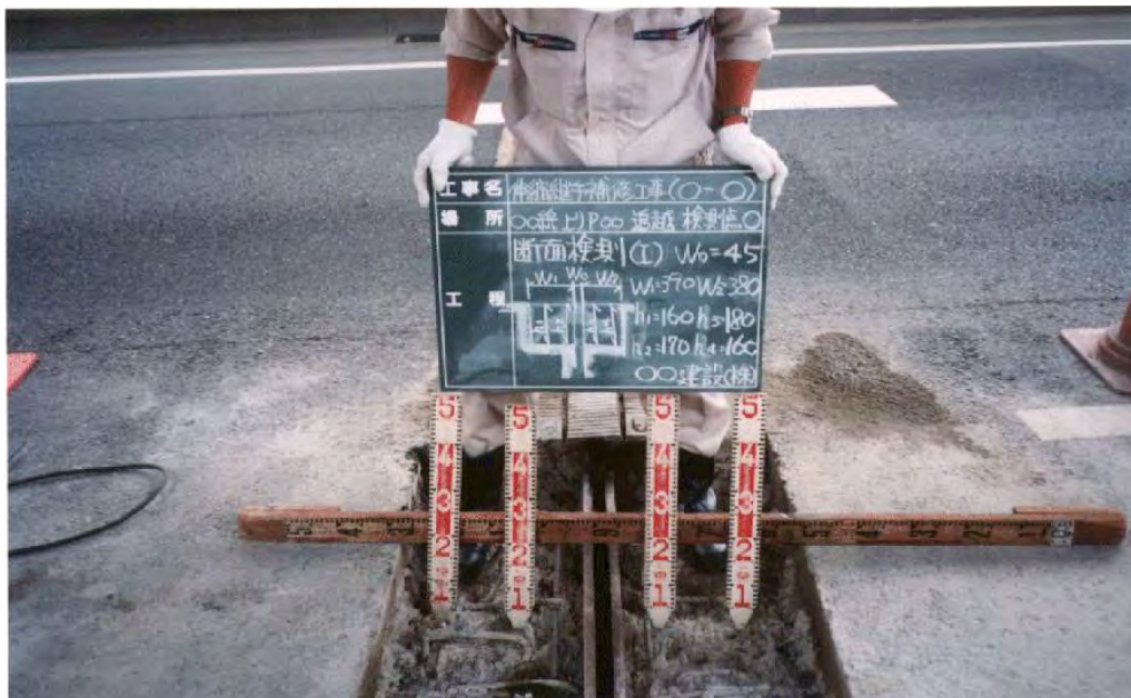
伸縮継手切削断面の計測
