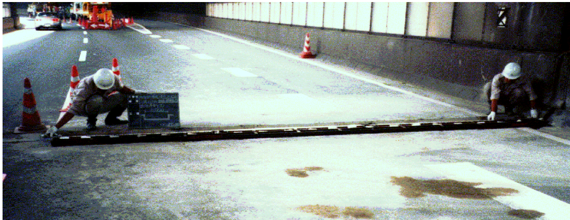
伸縮継手補修実長の全景の例
