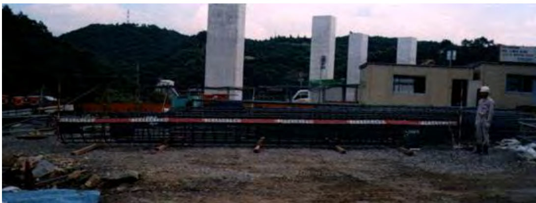
鉄筋かごの実長の全景の例
