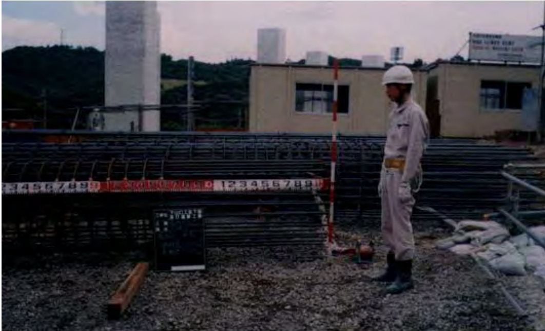
鉄筋かご実長の接写の例
