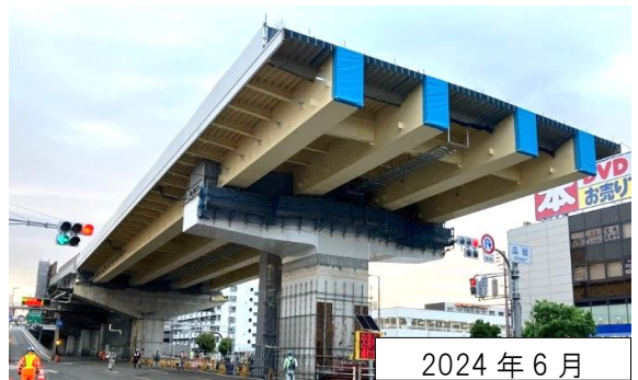
⑥側径間部の新設橋桁架設が完了
