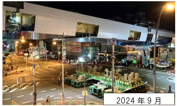
⑦中央径間部の橋桁を多軸台車で運搬し一括架設
