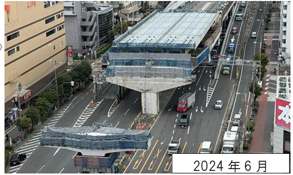
⑤本線上で組み立てた橋桁を送り出して架設
