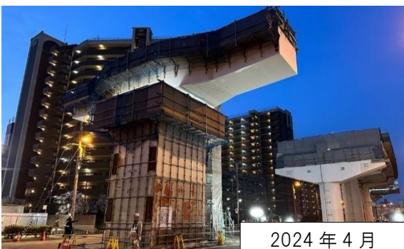
④新設の鋼製橋脚頭部の架設が完了
