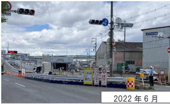
①喜連瓜破～三宅間で上下線通行止めを開始
