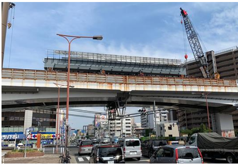
【高速道路上のクレーンによる仮設桁設置】
