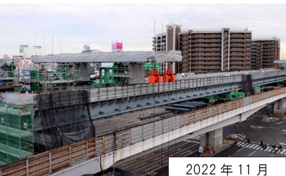
②仮設桁上から既設橋桁の撤去を開始
