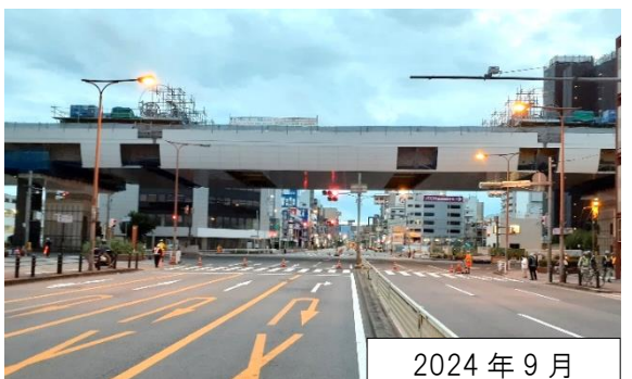
⑧中央径間部の新設橋桁架設が完了
