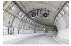
【トンネル内照明・換気設備の更新】
