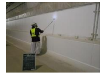
【老朽化した覆工コンクリートの補修】
