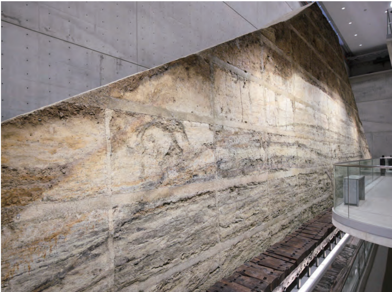
狭山池博物館に入っすぐ目にひく、狭山池から移築された巨大な堤の断面。積み重なる地層を見ると、狭山池誕生時から時代ごとに改修されていった様子がよくわかる。堤の下に展示されているのが全長約70mの江戸時代の東横箱型の樋管で、水が漏れないよう板の継ぎ目には樹皮を糊状にした「まきはだ」を詰める工夫がされている。
