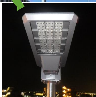
明かり部道路照明 (LED)
