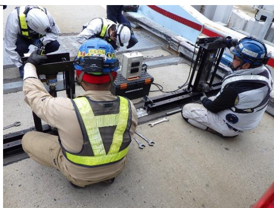
車両重量計設備定期点検
