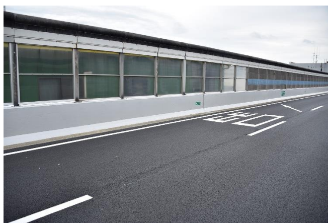
舗装補修（補修完了後）
