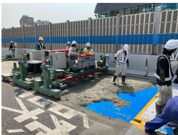
SFRC 舗装施工状況
