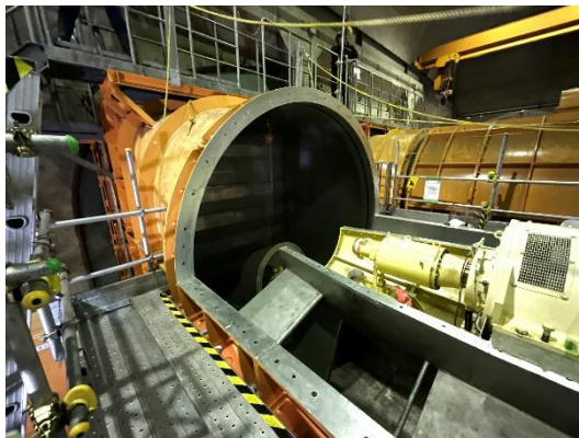
新神戸トンネル 南換気所 2号排風機 分解整備
