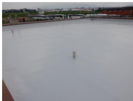
伊丹 TN 電気室屋上防水（補修後）
