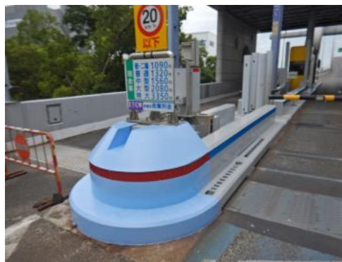
料金所アイランド損傷（補修後）
