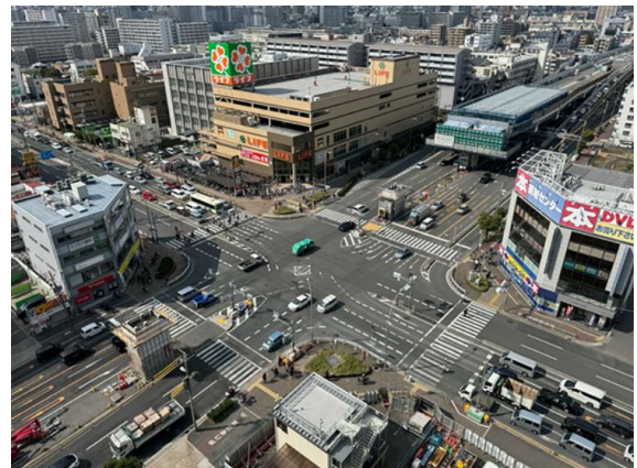
既設梁撤去後の状況
