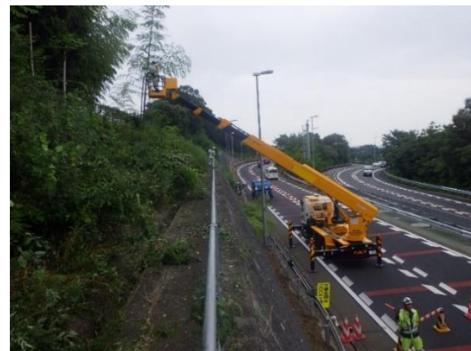
雑木伐採作業状況
