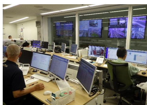
設備監視（兵庫地区）
