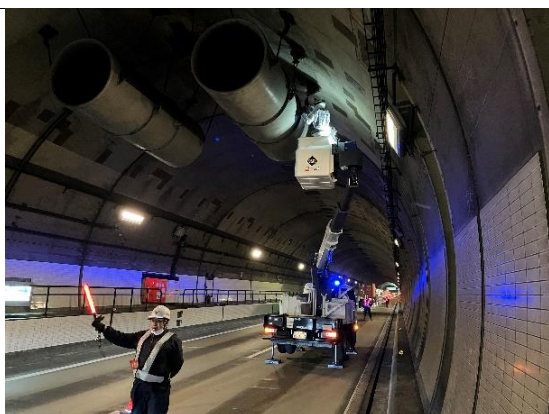
トンネル換気設備定期点検
