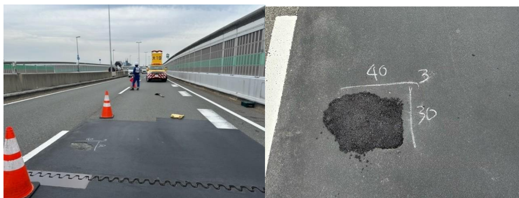
ポットホールの緊急対応の様子
