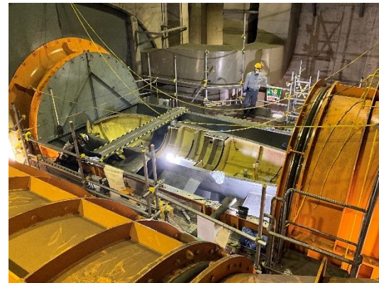
新神戸トンネル 南換気所 2号排風機 分解整備
