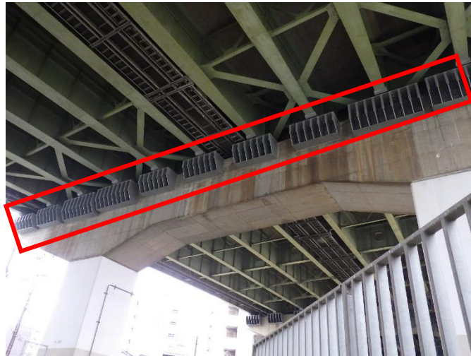
上部工の耐震補強
