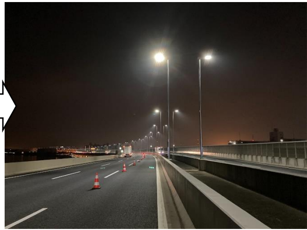
本線道路照明の取り替え後
