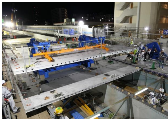
コンクリート床版の設置状況
