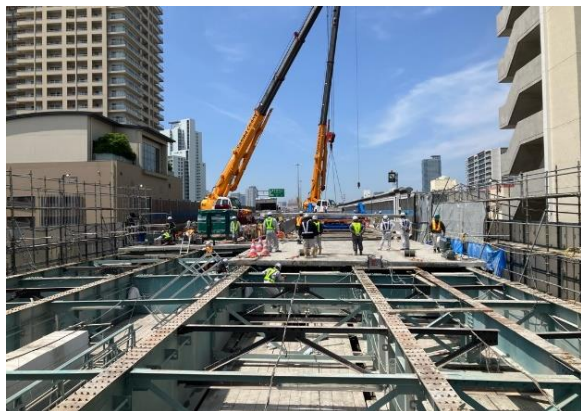
コンクリート床版の撤去状況
