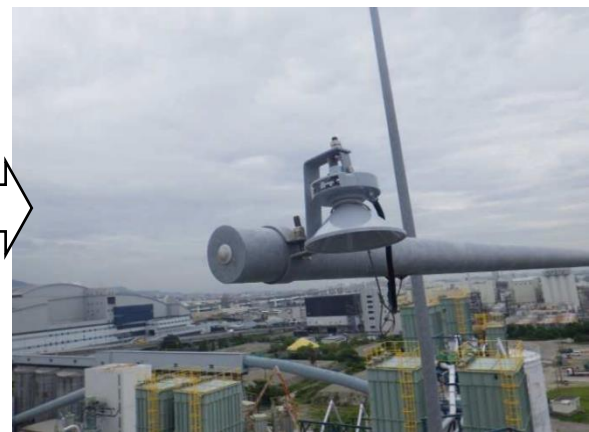
車両検知ヘッド補修後
