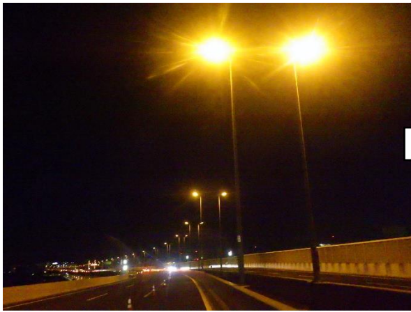
本線道路照明の取り替え前
