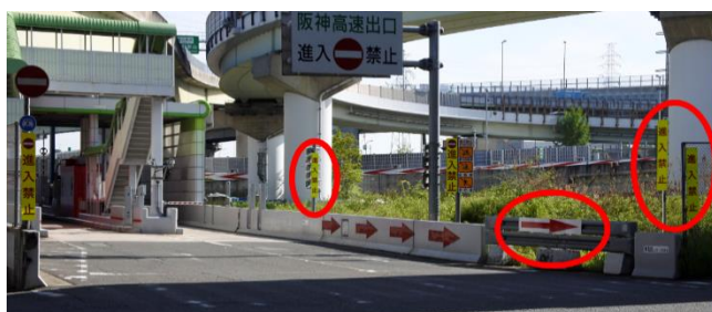
進入禁止看板及び側面矢印板の増設
