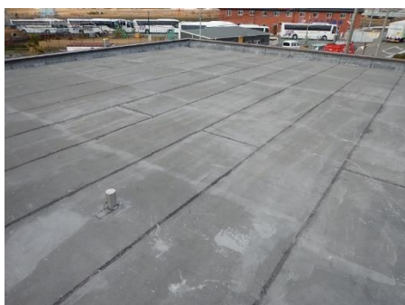
伊丹 TN 電気室屋上防水（補修前）
