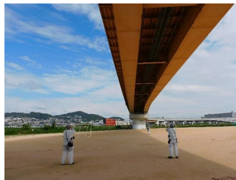
日常点検（路下）
