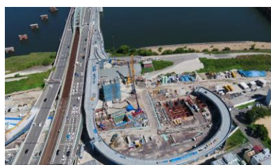
床版工・壁高欄工の実施状況
