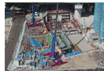
U型擁壁部躯体工事の実施状況
