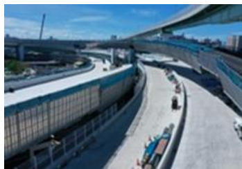
トンネル函体工事の実施状況
