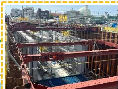
開削トンネル工事実施状況 (U型擁壁構築)
