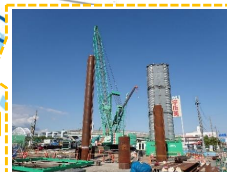
橋梁基礎工事の実施状況 (鋼管矢板基礎打設)
