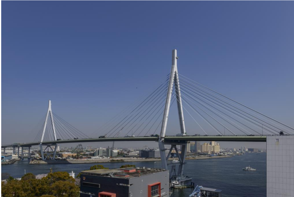
5号湾岸線 天保山大橋
