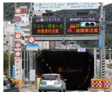
ネットワークに組み入れた 新神戸トンネル
