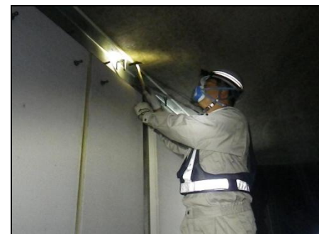
トンネル吊り材上部定着部付近の点検状況
