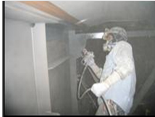
塗装塗替え施工状況
