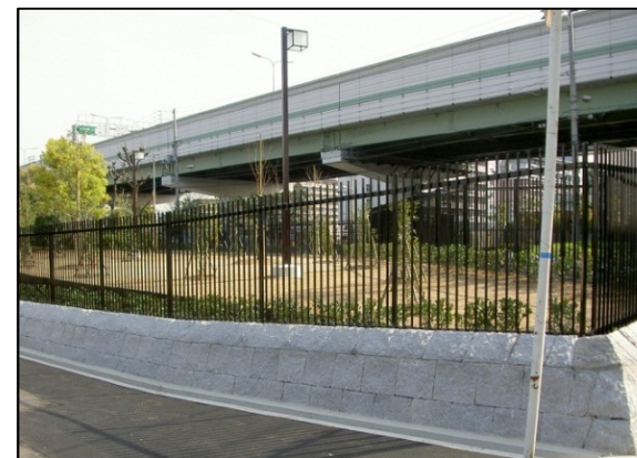
緩衝帯(環境施設帯)状況
