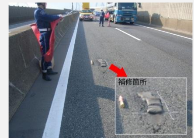
【事例】交通管理隊のポットホール補修による補修の効率化及び規制時間の短縮
