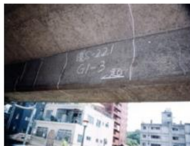
コンクリート桁の損傷(ひび割れ)
