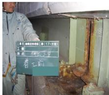
鋼桁部の損傷 (漏水による腐食)
