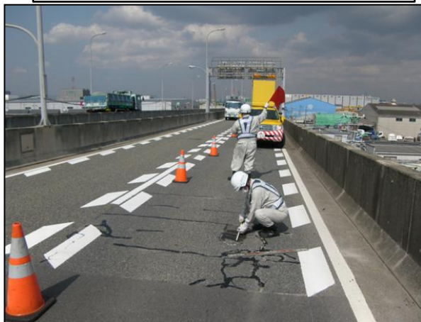
日常点検 路上点検
