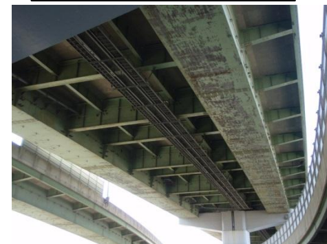
塗装塗替工事
