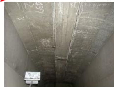
コンクリート桁の損傷(ひび割れ)
