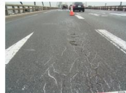
舗装の損傷(ひび割れ)
