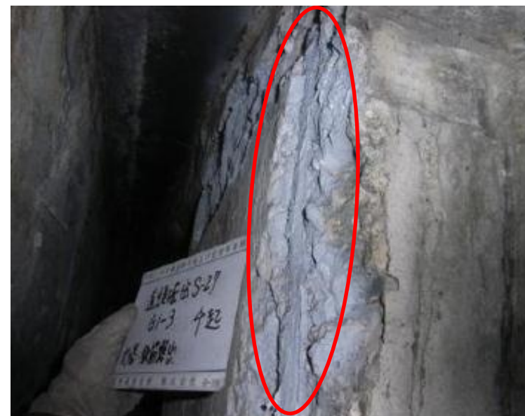
主桁の鉄筋露出
