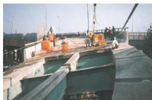
桁・橋脚の再構築等
