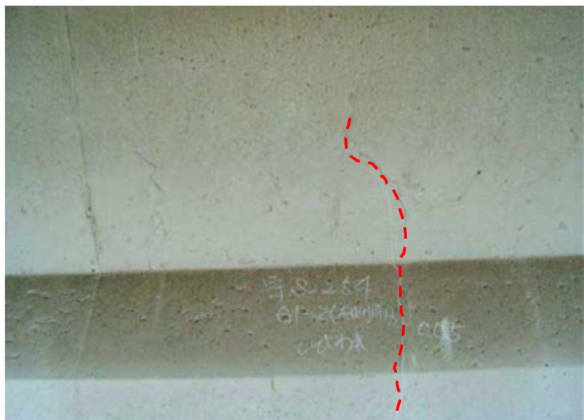
主桁のひびわれ
