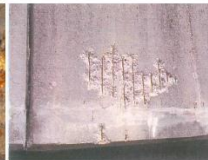
コンクリート高欄部の損傷 (剥離・鉄筋露出)
