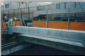
床版・高欄再構築等
