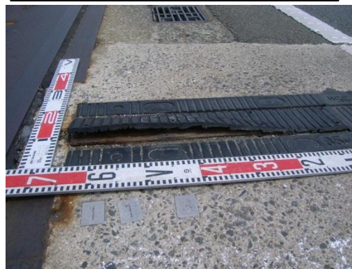
伸縮継手補修工事
