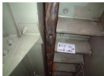
伸縮装置の損傷(止水破損)
