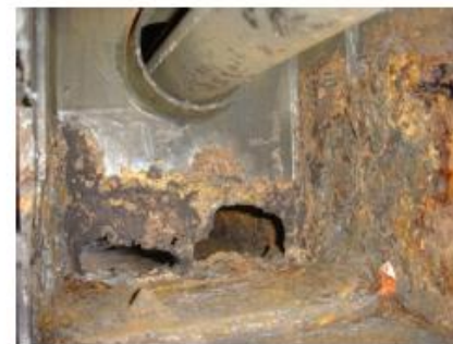
鋼製高欄部の損傷 (漏水による腐食)
