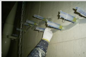
ひびわれ注入等
