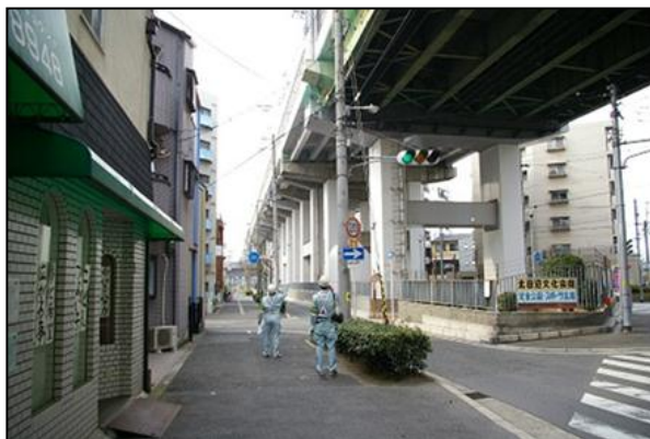
日常点検 路下点検
