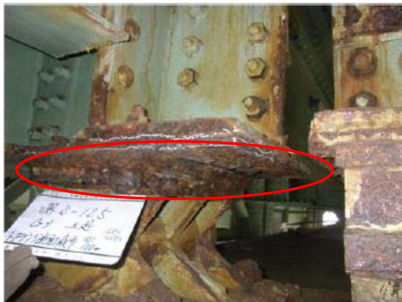
主桁端部下フランジの断面減少
