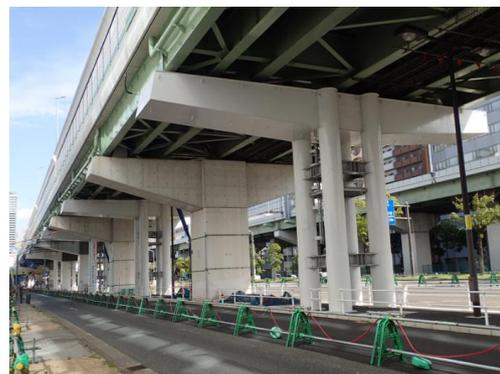
写真-1 鋼管集成橋脚 (西船場 JCT)
