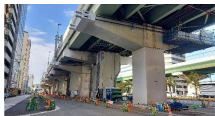
写真-1 PC 外ケーブル設置状況
