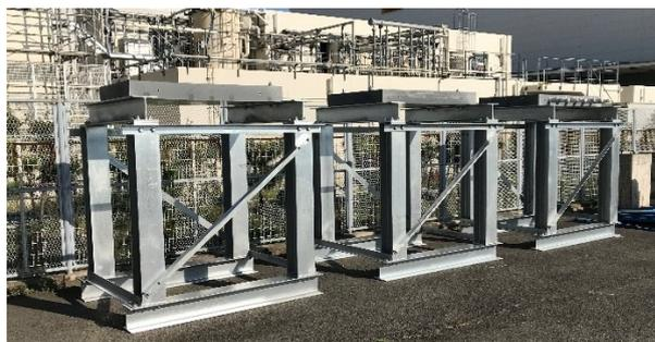
写真-1 製作・設置したテスト床版
