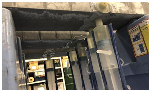
図-7 ひび割れ注入状況
