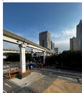
写真1 ポートアイランド内 建設予定地 (2023年2月撮影)
