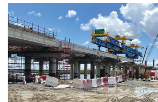
建設中のモンバサ南バイパス(ケニア)
