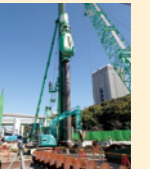
基礎工(六甲アイランド地区)
