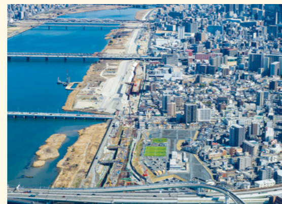
淀川の堤防沿いにトンネル構造で建設中の淀川左岸線(2期)
