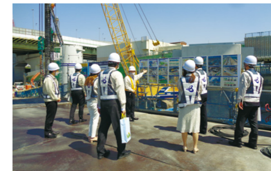
現場視察の様子
