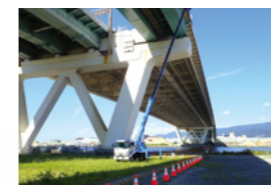
道路マネジメント・技術外販事業 (橋梁の点検)
