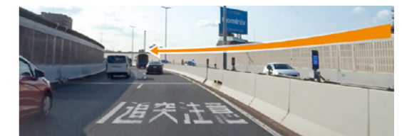
11号池田線(南行)塚本合流付近における速度回復誘導灯の設置
