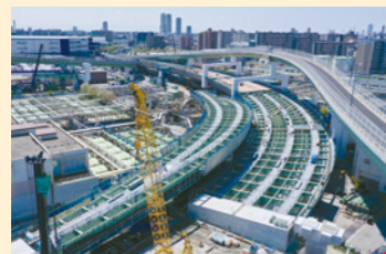
橋梁架設工(海老江地区)
