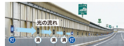
3号神戸線(東行)深江サグ部付近における速度回復誘導灯の設置
