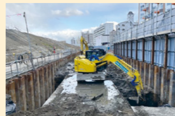
地中障害物撤去工事(豊崎地区)
