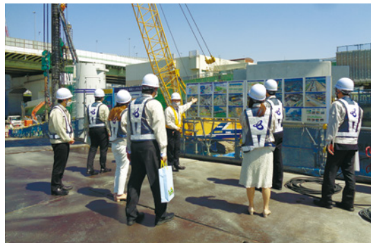
現場視察の様子
