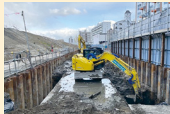
地中障害物撤去工事(豊崎地区)
