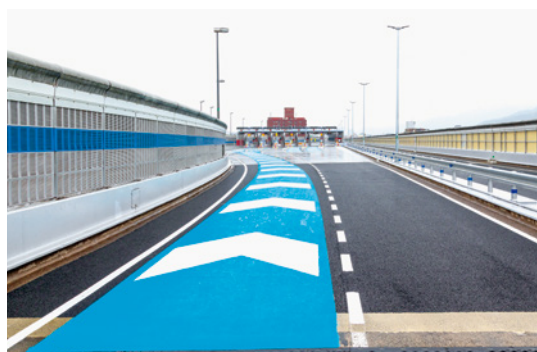
本線料金所の交通分散を図るカラー舗装
