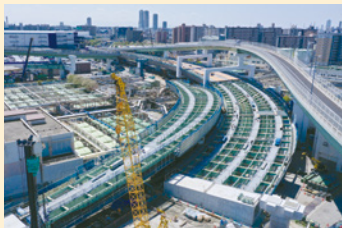
橋梁架設工(海老江地区)
