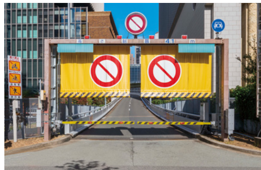
入口遠隔閉鎖装置（中之島入口）
