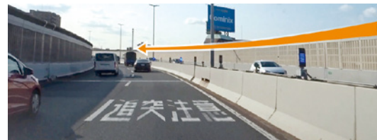
11号池田線(南行)塚本合流付近における速度回復誘導灯の設置
