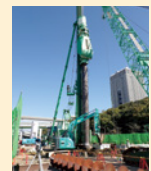
基礎工 (六甲アイランド地区)
