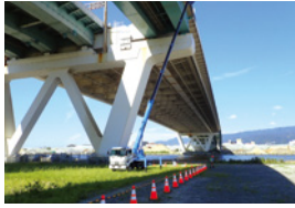
道路マネジメント・技術外販事業 (橋梁の点検)
