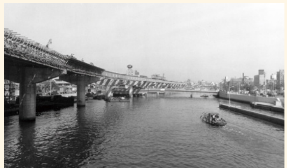
堂島川に建設中の環状線(中之島周辺)
