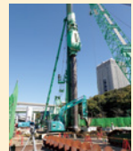
基礎工 (六甲アイランド地区)
