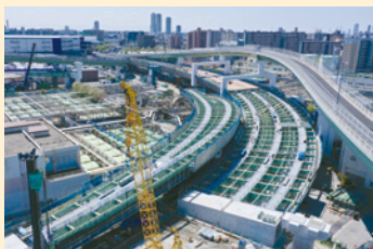
橋梁架設工(海老江地区)
