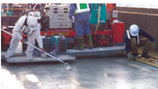
SFRC舗装施工
