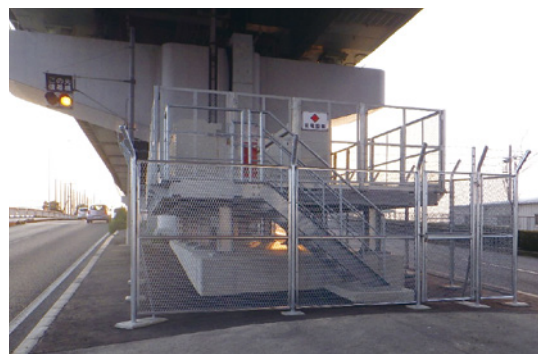
変電設備のかさ上げ
