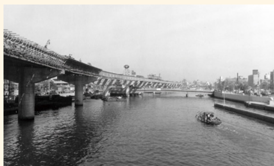
堂島川に建設中の環状線(中之島周辺)
