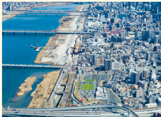
淀川の堤防沿いにトンネル構造で建設中の淀川左岸線(2期)
