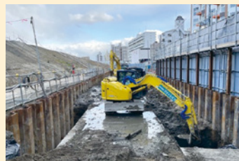
地中障害物撤去工事(豊崎地区)
