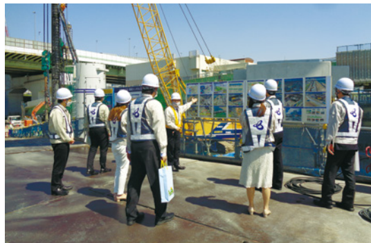
現場視察の様子
