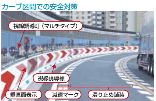
スリップ事故対策としての滑り止め舗装や、視認性向上のための視線誘導灯、視線誘導標の設置など、多彩な施策を実施。確かな効果が確認されています。
