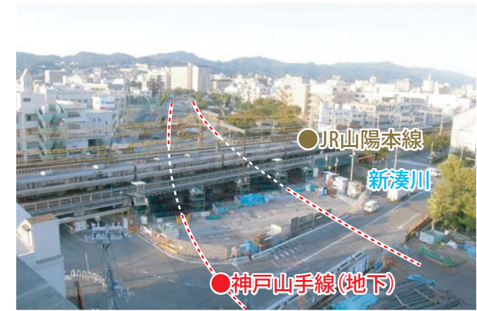
JR山陽本線交差部
