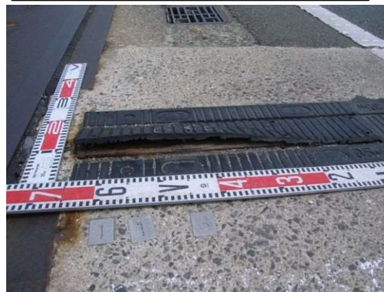
伸縮継手補修工事
