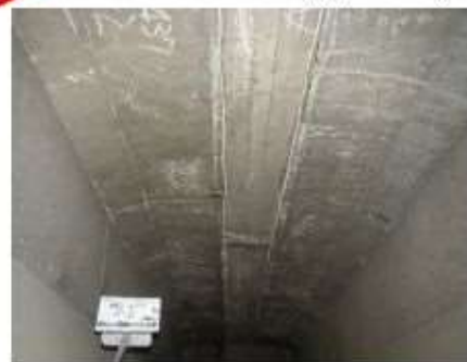
コンクリート桁の損傷(ひび割れ)
