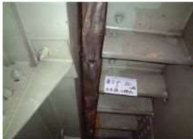
伸縮装置の損傷(止水破損)
