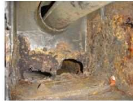
鋼製高欄部の損傷 (漏水による腐食)
