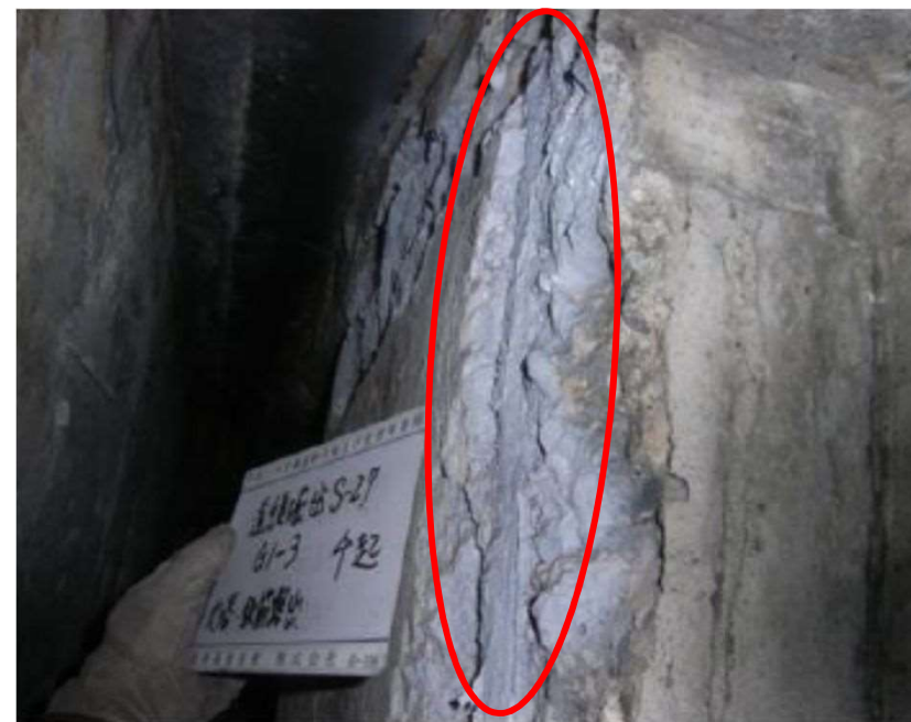
主桁の鉄筋露出
