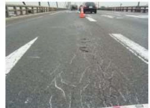
舗装の損傷(ひび割れ)
