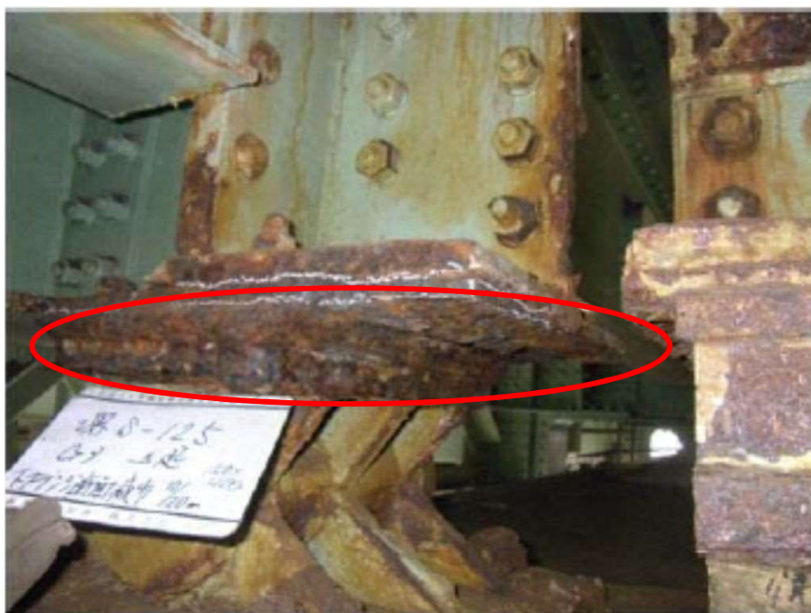
主桁端部下フランジの断面減少
