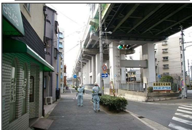
日常点検 路下点検
