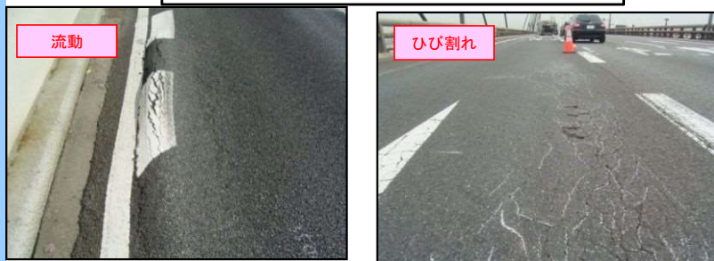
舗装補修工事
