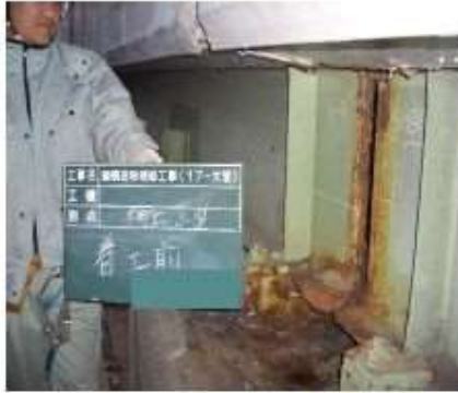
鋼桁部の損傷 (漏水による腐食)
