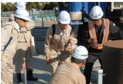
▲施工状況の確認を実施
