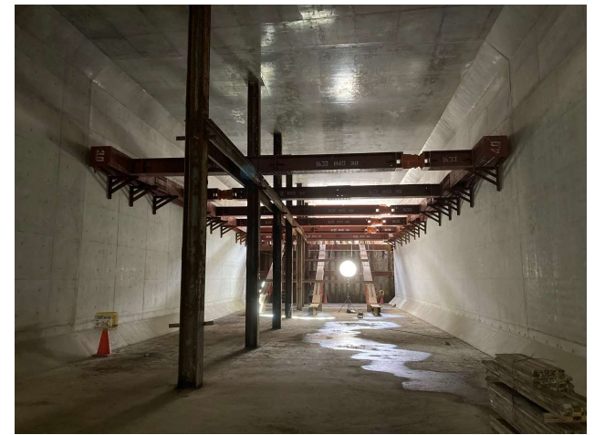
【2】施工区間⑤U-3、4ブロック 側壁コンクリート打設完了
