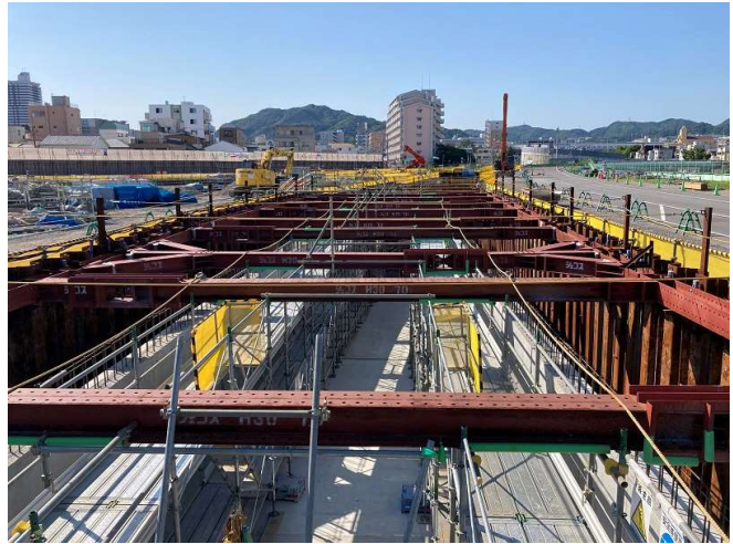
【2】施工区間⑤U-3、4ブロック 側壁コンクリート打設完了
