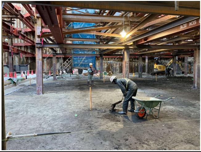
【1】施工区間① 2-2ブロック掘削状況
