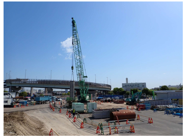
【3】高速道路の橋脚(PPE-3)基礎工事に於いて、地中障害物の撤去中。
