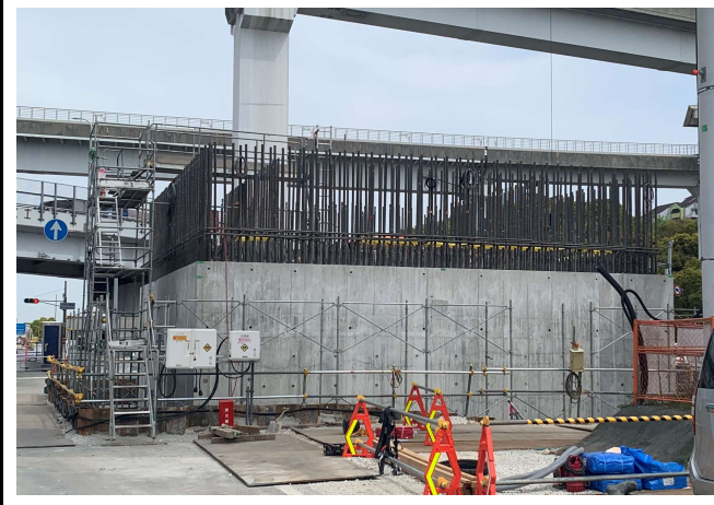
【2】高速道路の橋脚(PPE-7)ニューマチックケーソン基礎工事に於いて、1口目目のコンクリート打設完了。
