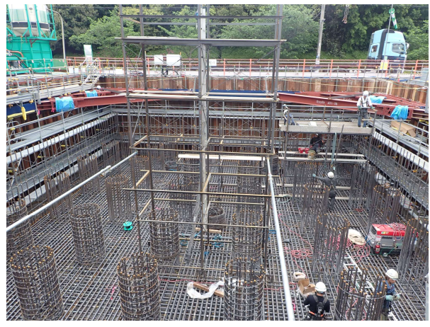
【1】高速道路の橋脚(PE-1)基礎工事に於いて、フーチング構築に向けた鉄筋組立中。
