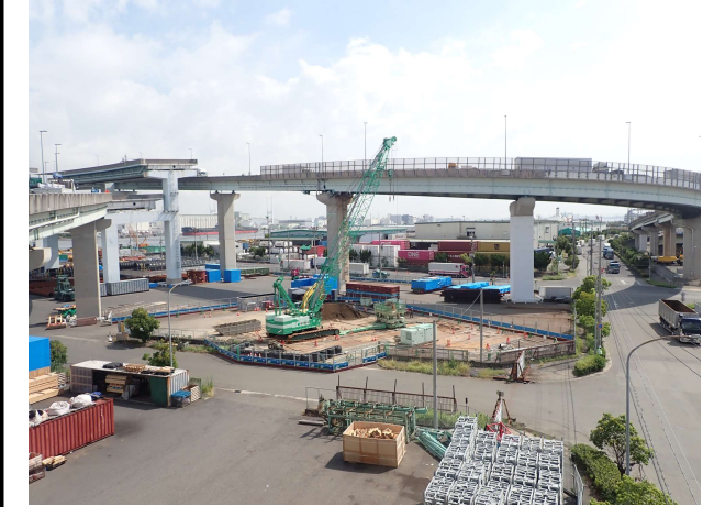
【3】高速道路の橋脚(PPE-1)基礎工事において、地中障害物の撤去中。
