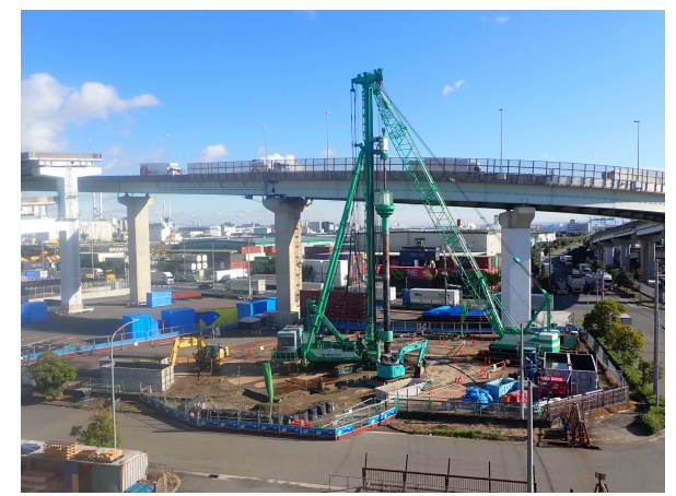
【3】橋脚(PPE-1)基礎工事中において、鋼管矢板継手部の先行削孔状況。
