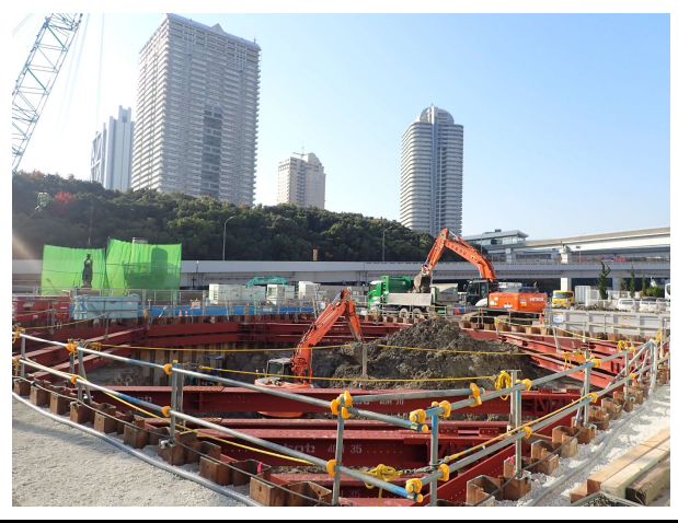
【2】橋脚(PPE-5R)基礎工事中において、土留支保工の設置状況。
