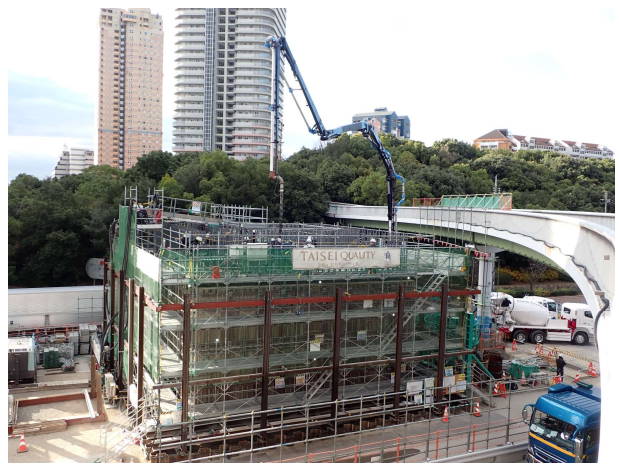
【2】橋脚(PPE-7)基礎工事に於いて、8ロット目のコンクリート打設状況。
