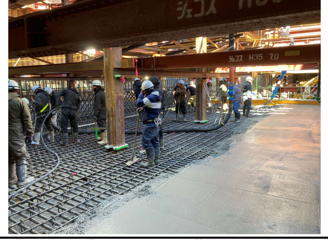
【2】施工区間① 3ブロック 底版コンクリート打設状況
