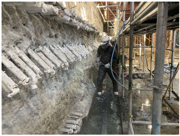
【1】施工区間① 1-2ブロック 既設函体と接続するため、一部函体の研(はつ)り工実施状況
