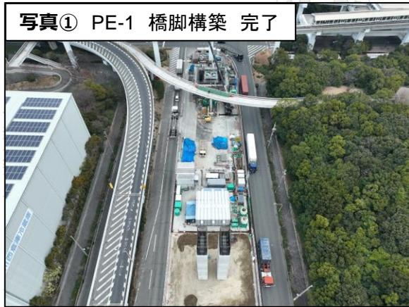
写真① PE-1 橋脚構築 完了
