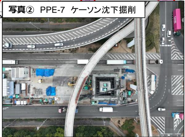
写真② PPE-7 ケーソン沈下掘削
