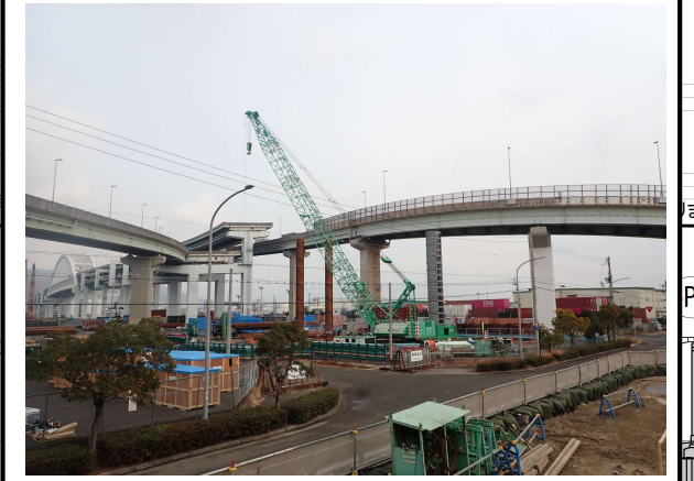
【3】橋脚基礎工事(PPE-1)における、鋼管矢板の打込状況。
