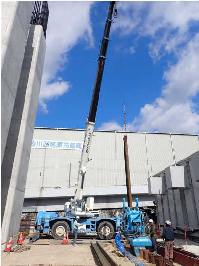
【1】橋脚工事(PE-1)における、鋼矢板の引抜状況。
