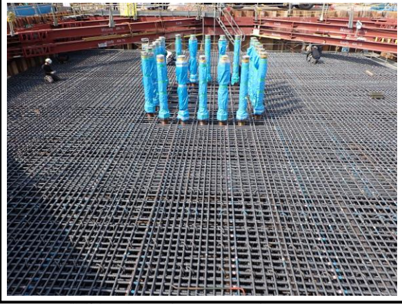
【2】橋脚工事(PPE-5R)において、フーチングの鉄筋組立完了。
