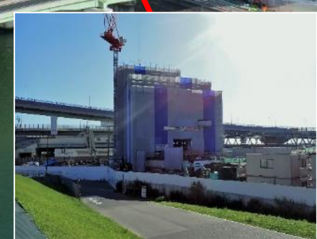
③換気所屋上階部の構築
