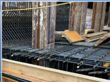
④底版コンクリートの型枠組立
