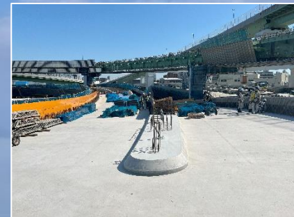
①床版の施工
