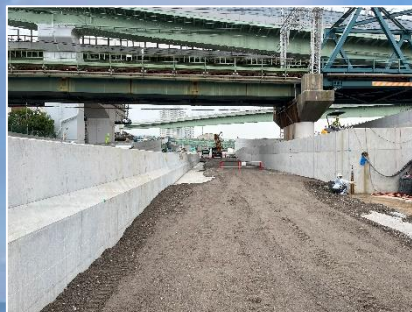
②路床の施工
