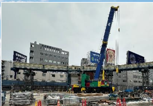
①桁架設工
