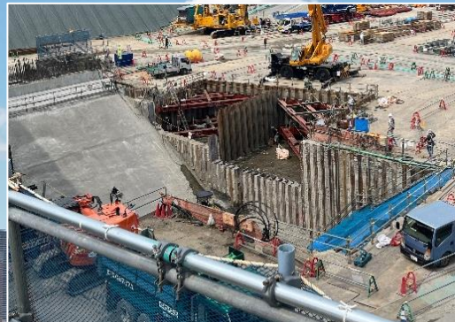
②擁壁部の掘削工
