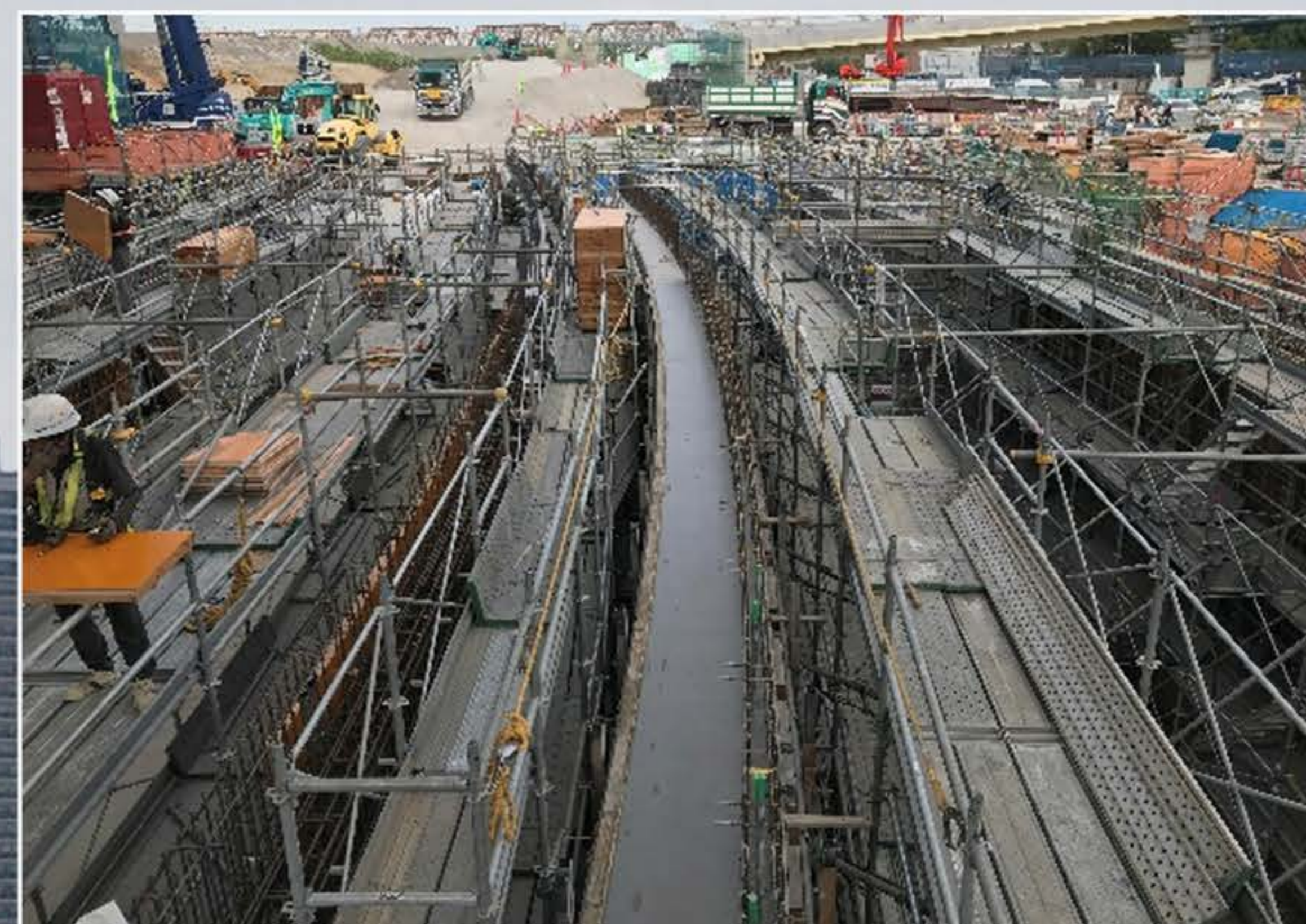
②擁壁部の躯体工
