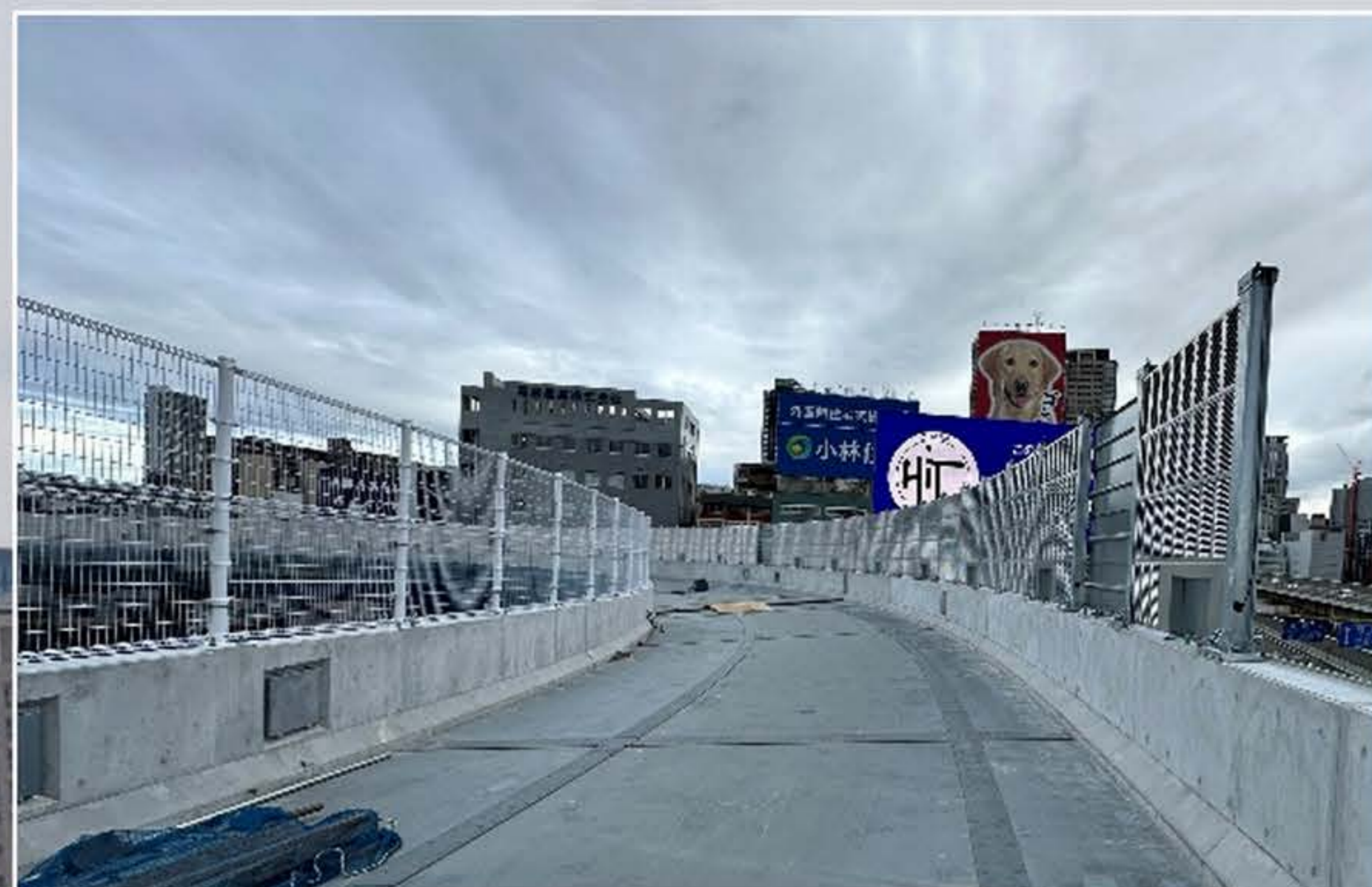
①遮音壁設置工
