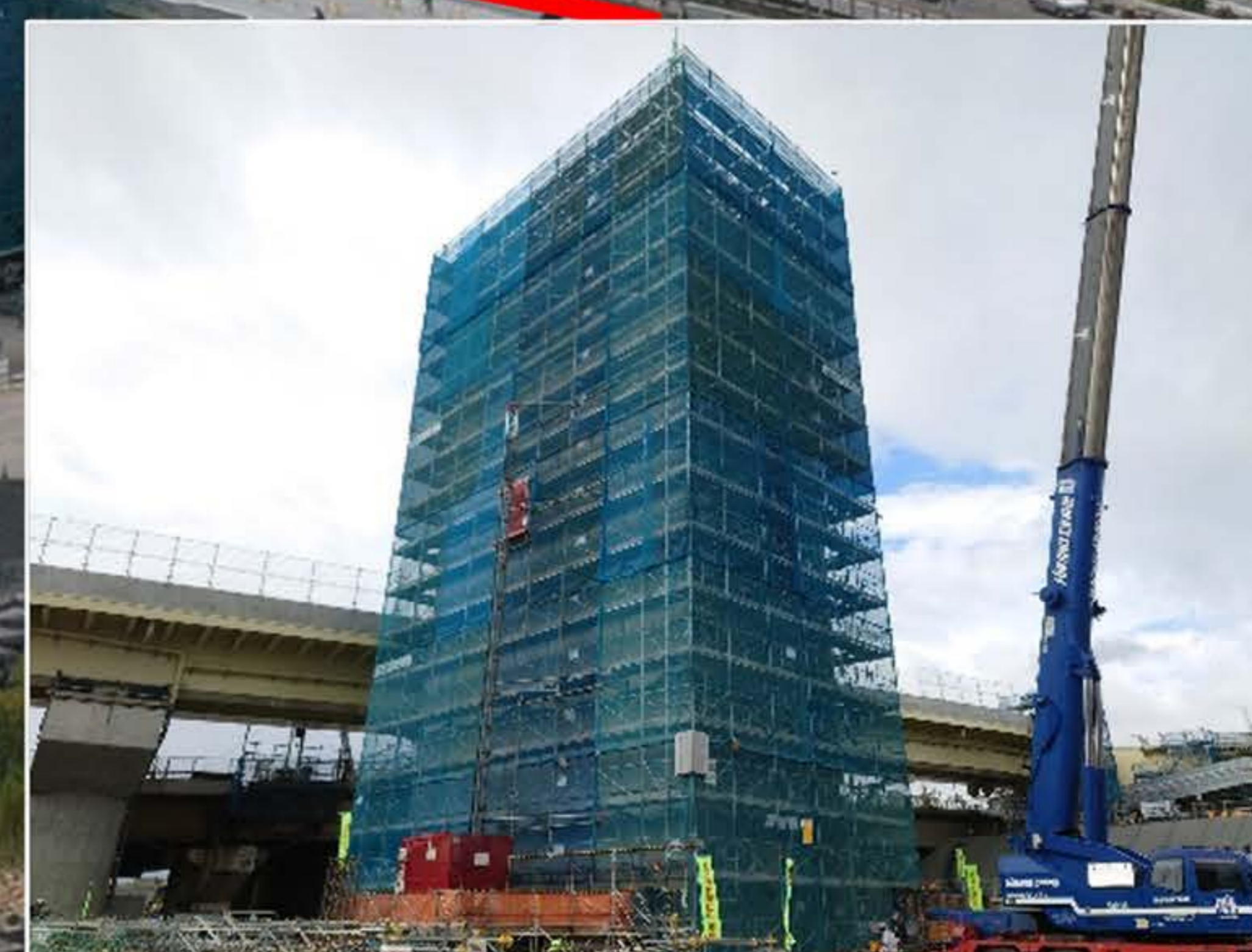
③換気塔部の躯体工
