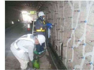
ひび割れ注入工法のイメージ
