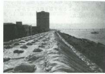
写真5.3.1 第一次緊急復旧工事
