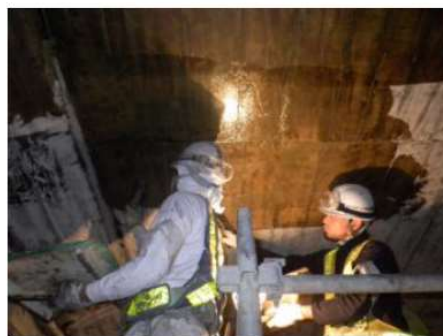
図 4.7.2-1 頂版におけるたたき点検のイメージ
