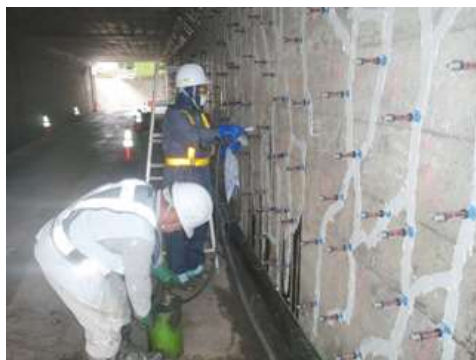
図 4.7.2-14 ひび割れ注入工のイメージ
