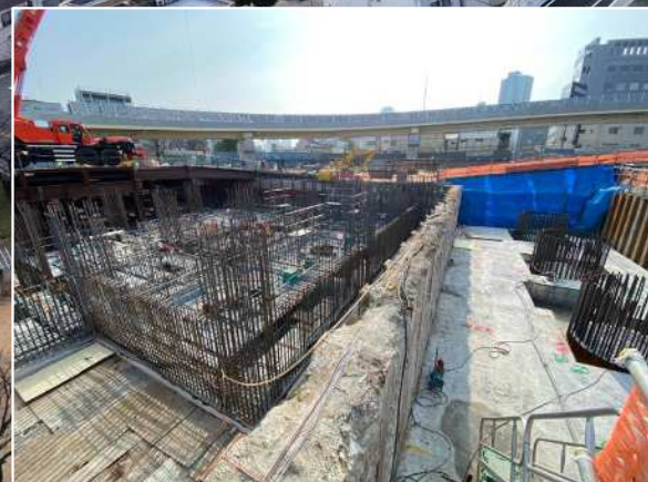
④受電所の躯体工
