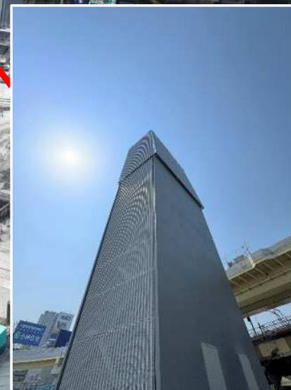
①換気塔 建物完成
