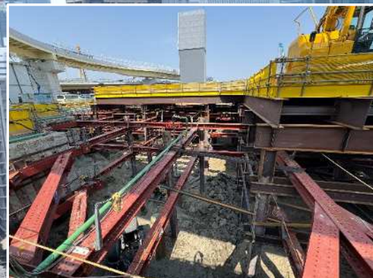
③換気所 掘削工
