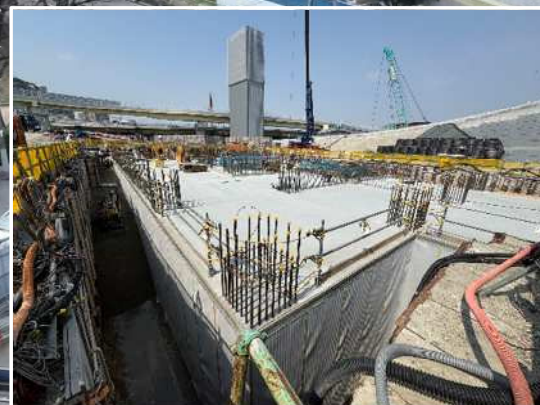
②受電所 地下躯体工完了
