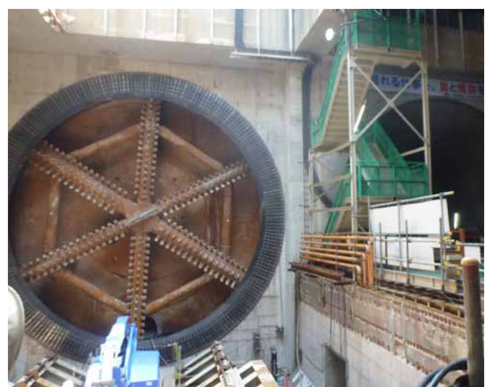
※阪神高速6号大和川線建設現場
