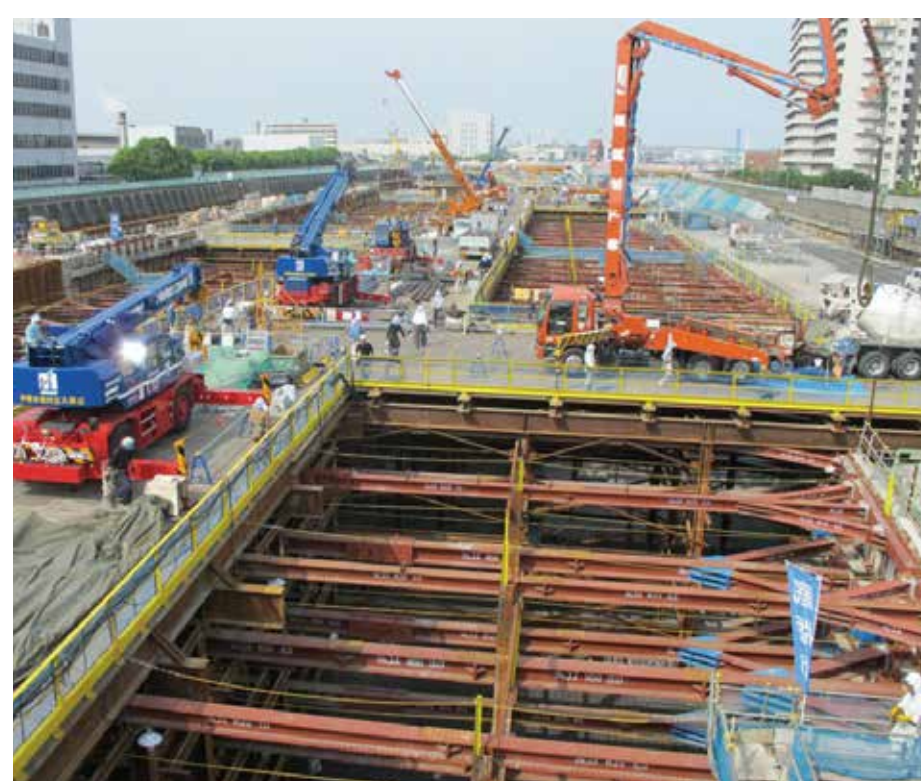
※淀川左岸線(1期)開削トンネル構築状況
