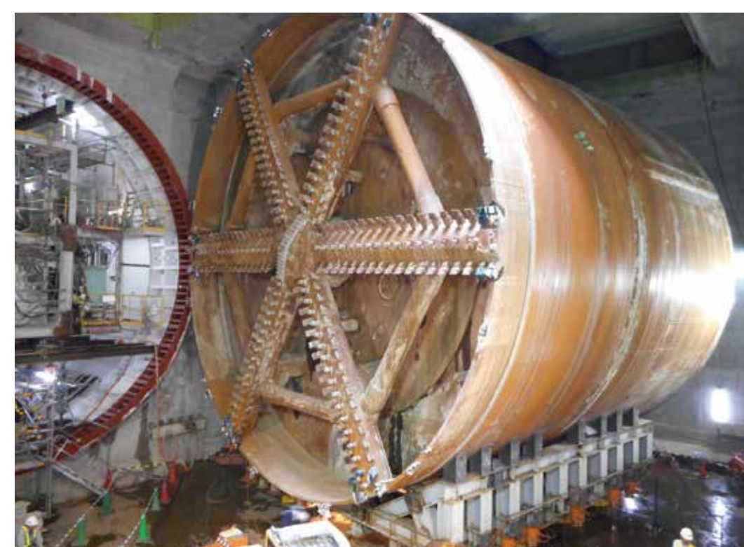
※阪神高速6号大和川線建設現場
